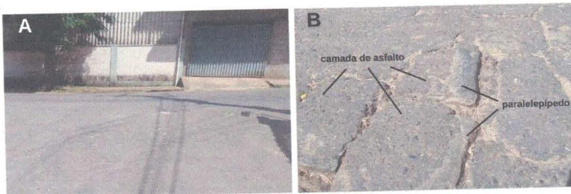
Figura 2. (A) Entrada da rua. Em (B), os paralelepípedos e manta asfáltica estão em destaque.
