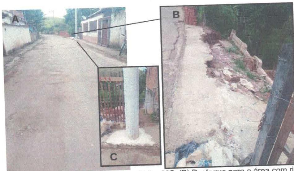
**Figura 4.** (A) Buracos em frente às casas 825 e 835. (B) Destaque para a área com risco de desabamento. (C) Poste transladado a após recomendação da Defesa Civil.
